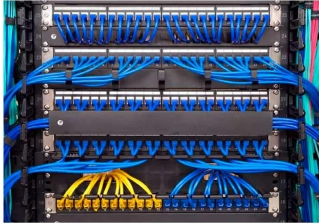
Şəkil 3.14. Yamaq panel
